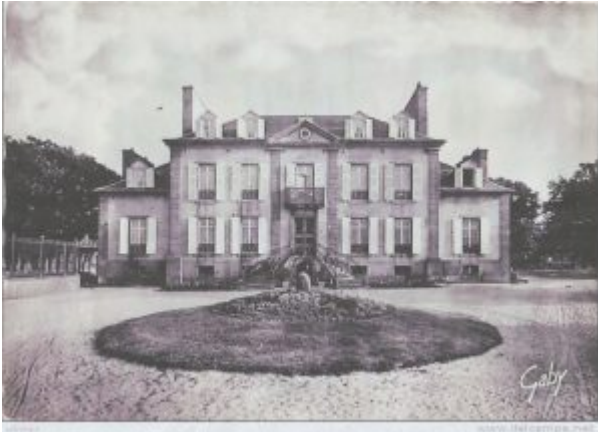
Le CONQUET. Ancien hôtel Beauséjour puis colonie de vacances de la ville de Brest
